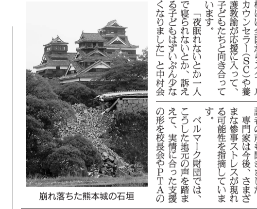
崩れ落ちた熊本城の石垣
