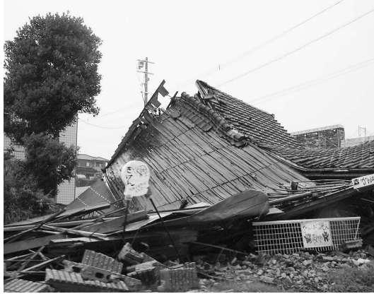
被災した学校の校舎の瓦が崩れ落ち、瓦礫が散らかっている。熊本市、益城町境内
