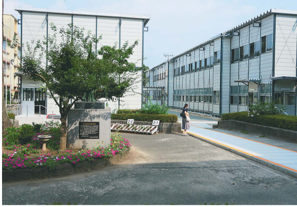
仮設の校舎で学んでいます。熊本市立東野中学校
